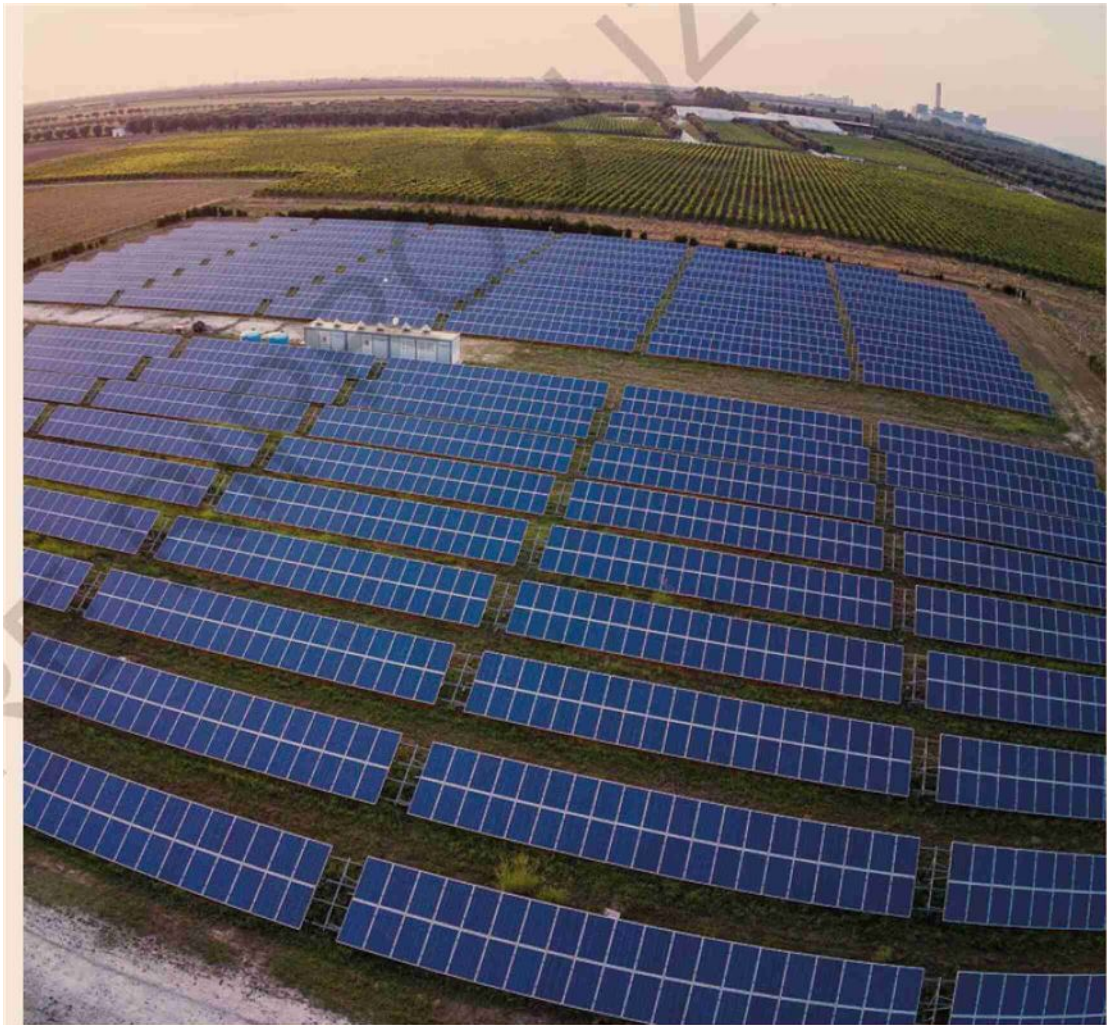
L'appello. Nuove installazioni a picco (nella foto un impianto fotovoltaico). Le imprese: «Semplificare le autorizzazioni»
